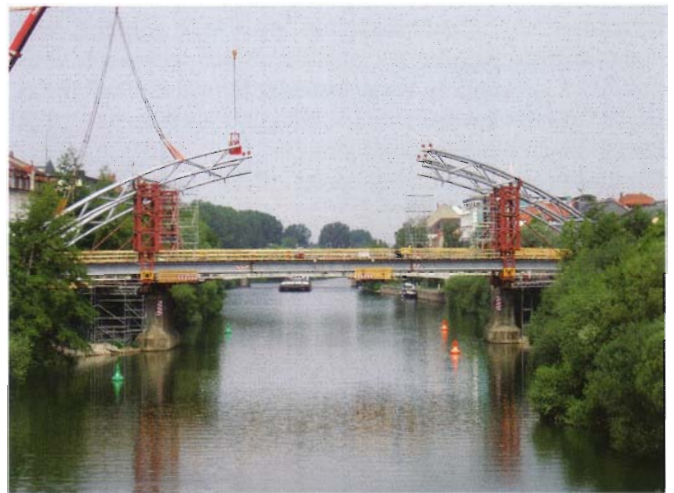
Bild 20. Montage des Stahlüberbaus Fig. 20. Assembly of the steel superstructure
