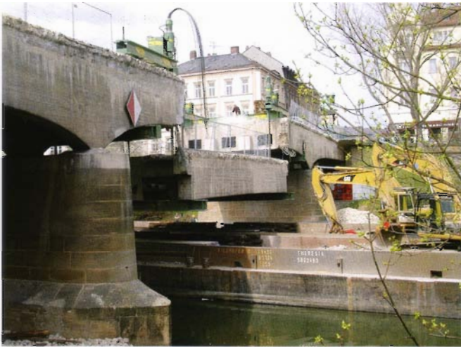
Bild 14. Absenken des Überbaus mit Litzenhebern Fig. 14. Move down the superstructure
