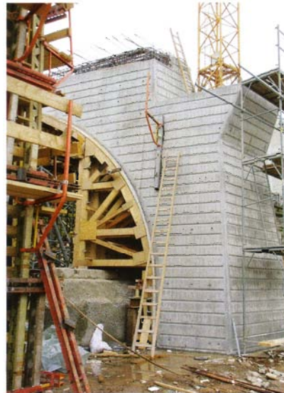
Bild 15. Strebepfeiler der Vorlandbrücke in der Schalung Fig. 15. Buttress of the pre-land bridge in casing
