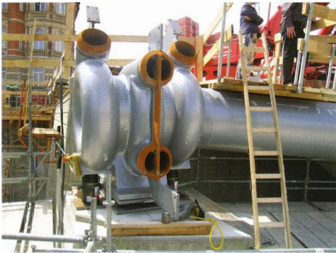
Bild 8. Gussknoten mit Endquerträger Fig. 8. Cast knot with final crossbeam
