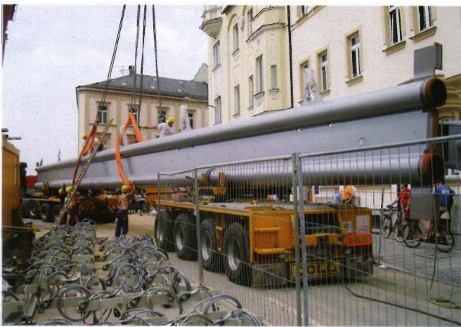
Bild 11. Montage des Zugbandes Fig. 11. Assembly of the tie rod
