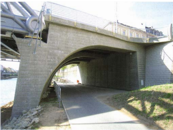
Bild 4. Östliche Vorlandbrücke Fig. 4. Eastern pre-land bridge
