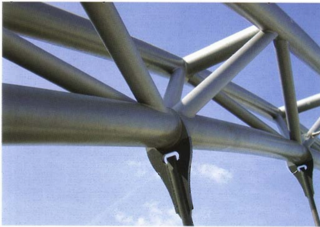
Bild 10. Hängeranschluss Fig. 10. Connecting point hanger
