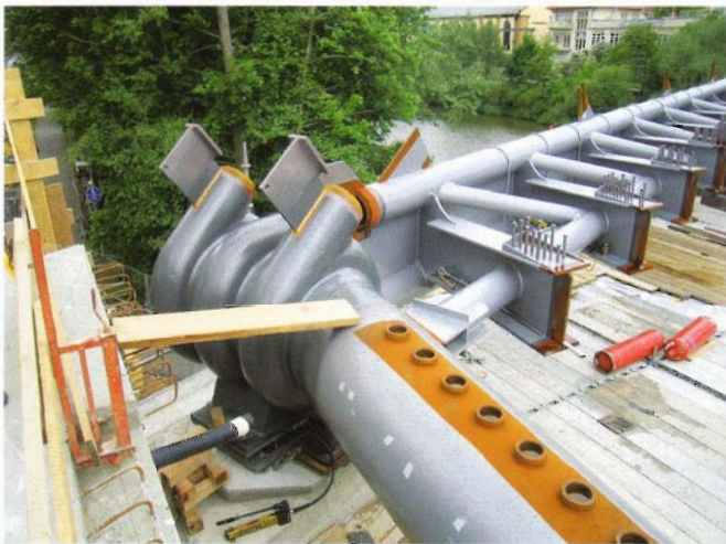
Bild 19. Einrichten des nördlichen Zugbandes am Gussknoten Fig. 19. Setting up the northern tie rod at the cast knot
